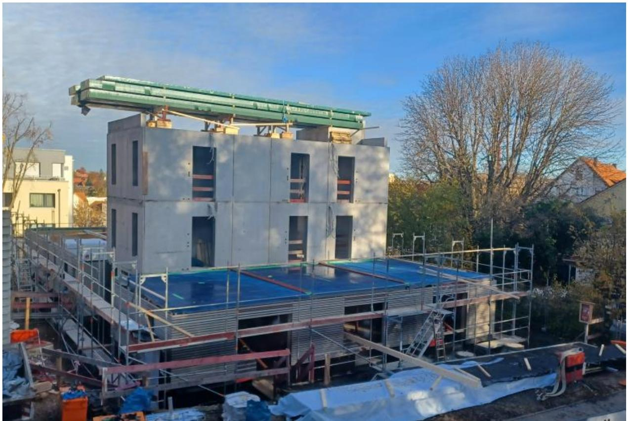
*Die Baustelle im November: Der Neubau entsteht überwiegend in Holzbauweise. Das Treppenhaus wird massiv gebaut und ist dadurch vor den Holzelementen im Rohbau dran.*
