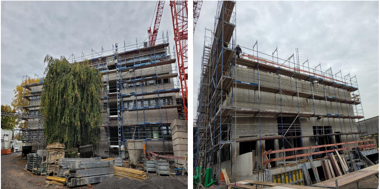
Blick auf das Bestandsgebäude (links) und auf den Neubau (rechts) mit derzeit zwei nahezu fertiggestellten Stockwerken (Stand 10/2023).
