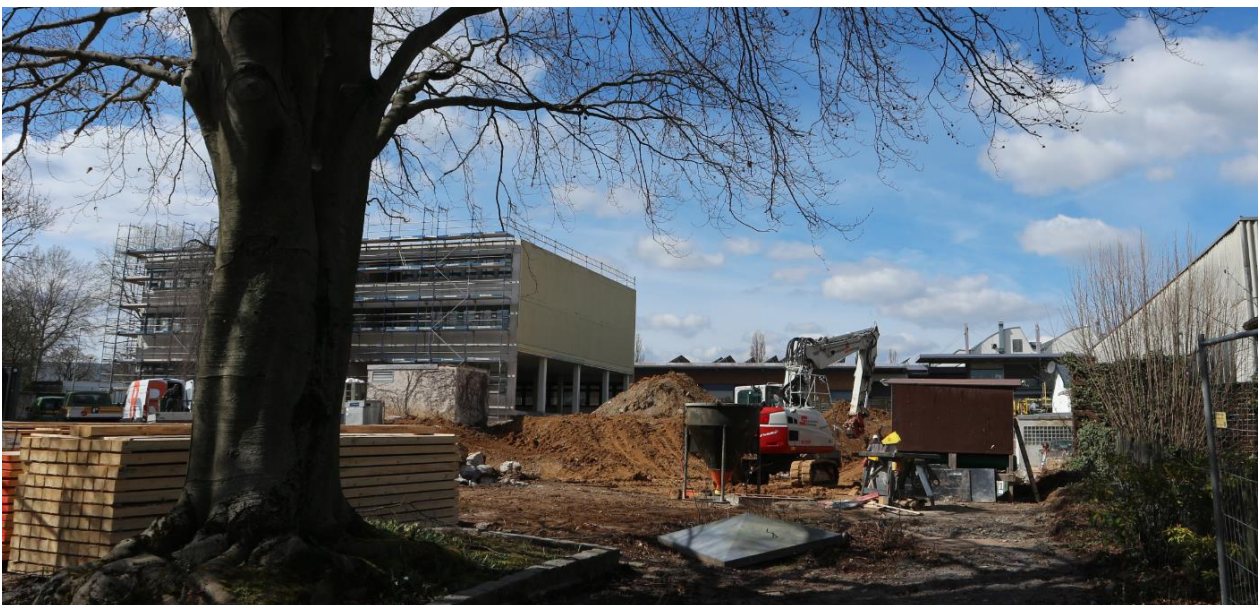
Blick auf die Baustelle in der Herrmann-Hess-Straße 14-16 Ende April
